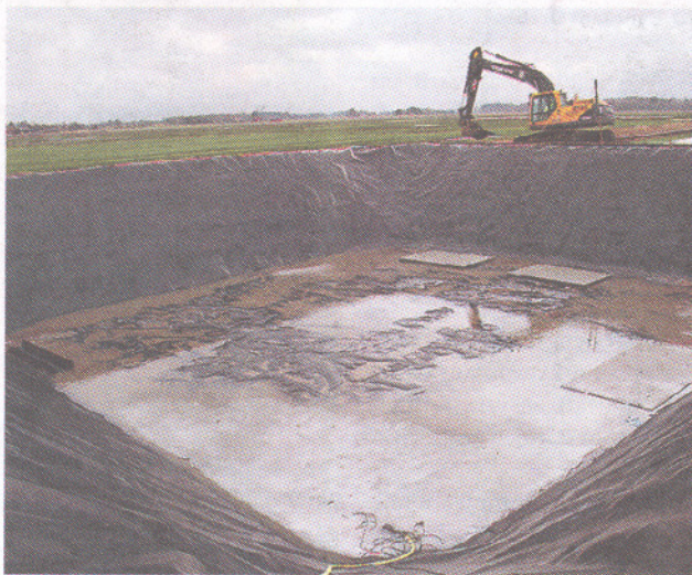
Att anlägga en dukinklädd bassäng kan vara ett billigt alternativ till en betongbrunn.
