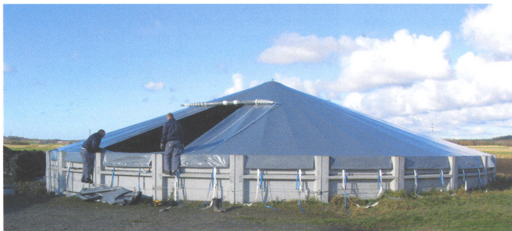
De store luger på MPG-tanktoppen betjenes med et håndsving, så én mand kan åbne lugen.
